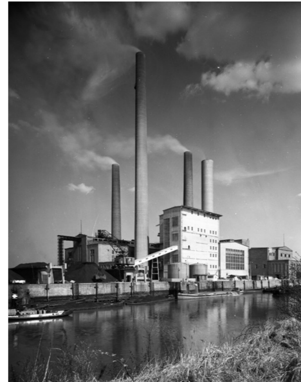
HEW Kraftwerk Neuhof, Bestand: Ursula Becker-Mosbach, Nachlieferung, Scan vom Glasplatten-Negativ, 13/18 cm
