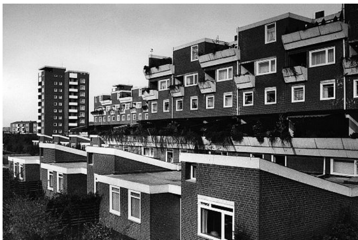
Ingeborg und Friedrich Spengelin: Terrassenhaus in der Siedlung Holsteiner Chaussee in Eidelstedt, 1966-69 (Fotoarchiv SAGA / Museum der Arbeit)
