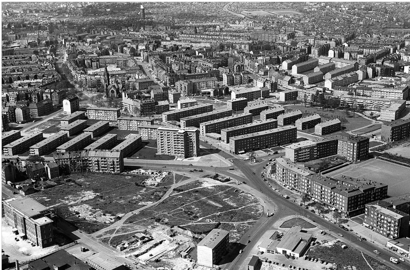
Luftbild von Eimsbüttel, um 1959. Im Bildmittelgrund links: SAGA-Bebauung von Bernhard Hermkes nördlich des Eimsbütteler Marktplatzes (StaHH, Plankammer)
