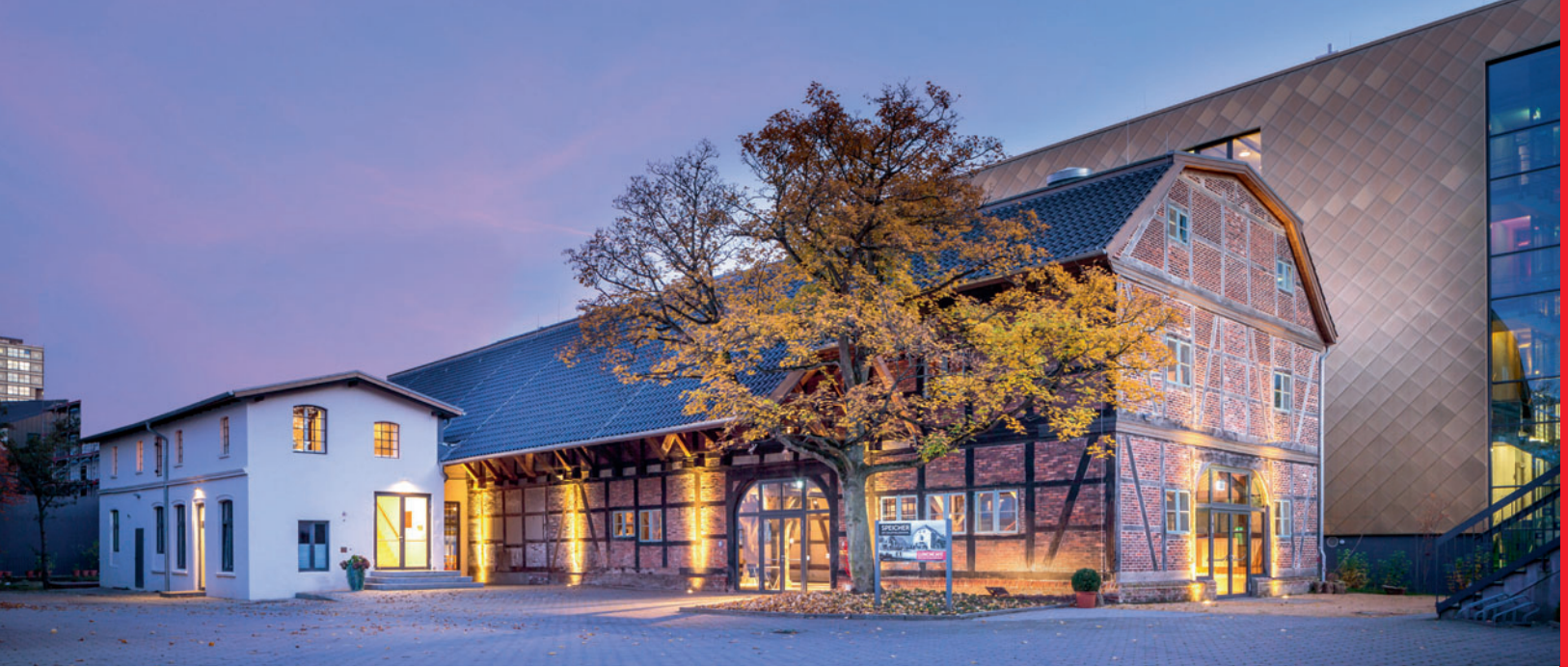
Speicher am Kaufhauskanal (Foto: Richard Stöhr)
