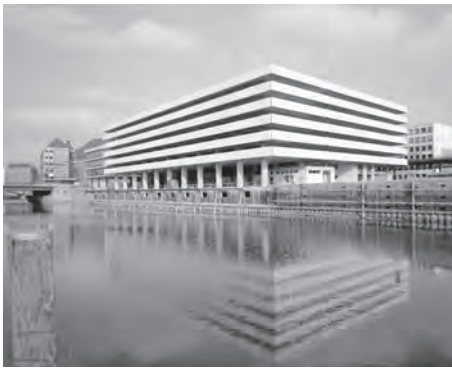
Oben: Baustelle Sheddachhalle mit HP-Schalen Bild: © Hamburgisches Architekturarchiv, Otto Rheinländer; unten: Hochgarage Rödingsmarkt, Bild: © Hamburgisches Architekturarchiv, Otto Rheinländer; rechts: HEW Haldesdorferstrasse, Bild: © Hamburgisches Architekturarchiv, Otto Rheinländer;
