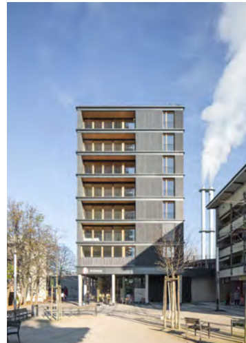
Links: Team3 – Ökologisches Wohnquartier in Passivbaustandard, München, Architekturwerkstatt Vallentin, München, Foto: Lukas Vallentin; rechts: Buggi 52 – Wohn- und Gewerbebau mit Kita, Freiburg-Weingarten, Weissenrieder Architekten, Freiburg, Foto: Jochen Weissenrieder
