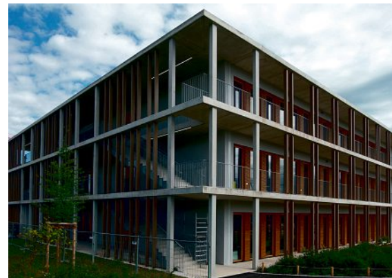
Modulare Grundschule, Architekten: Wulf Architekten, Stuttgart © Claudia Neeser
